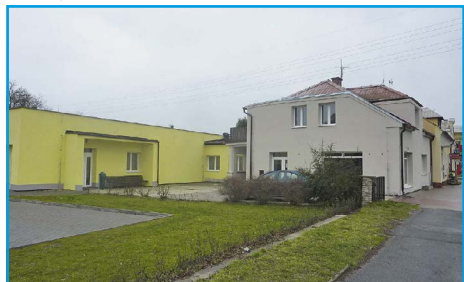
■ V posledních březnových dnech byla na budově oční optiky a oční ambulance dokončena nová fasáda
