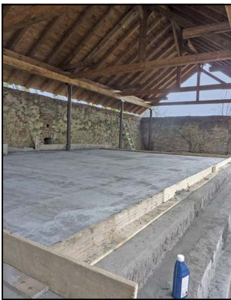
■ Pódium pod přístřeškem na Plajchu je připraveno pro pokládku dřevěné podlahy
