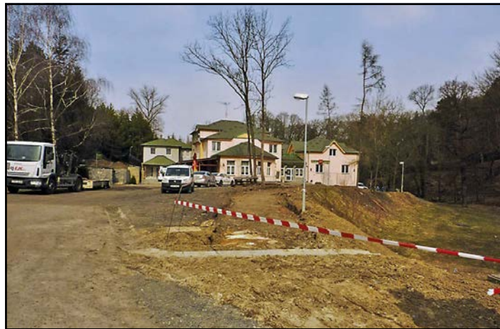
■ Podpora cyklodopravy – úprava tělesa stezky a instalace nového veřejného osvětlení na stezce
