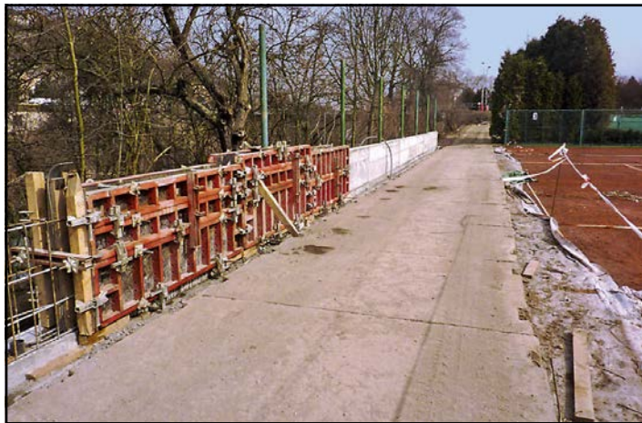
■ Protipovodňová opatření – betonování protipovodňových zábran u tenisového areálu
