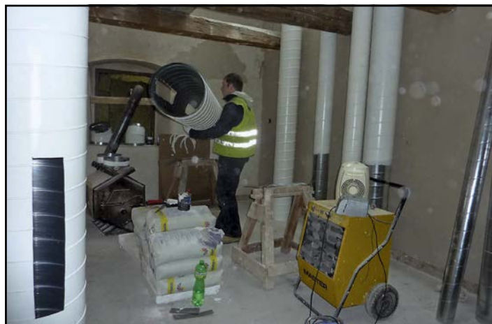
■ Montáž vzduchotechniky na Plajchu
