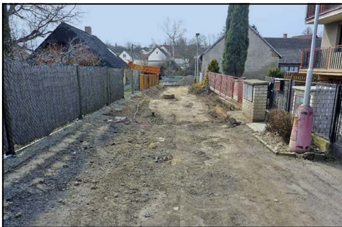
■ Oprava ulice Kordinů – úprava podkladních vrstev komunikace
