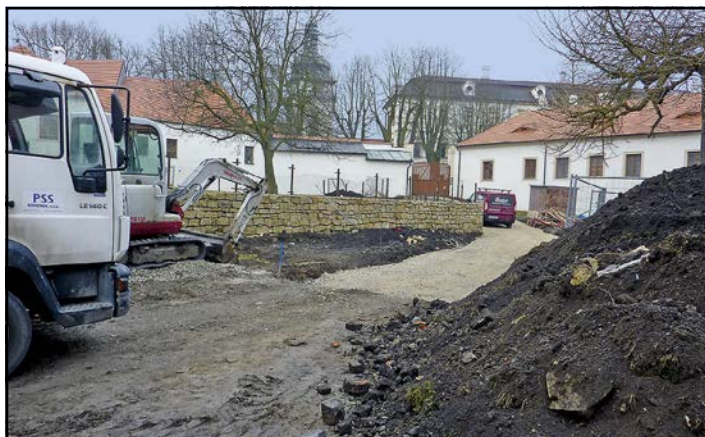
■ Rekonstrukce plochy u zámku a domu čp. 172 na Plajchu – podkladové vrstvy komunikace
