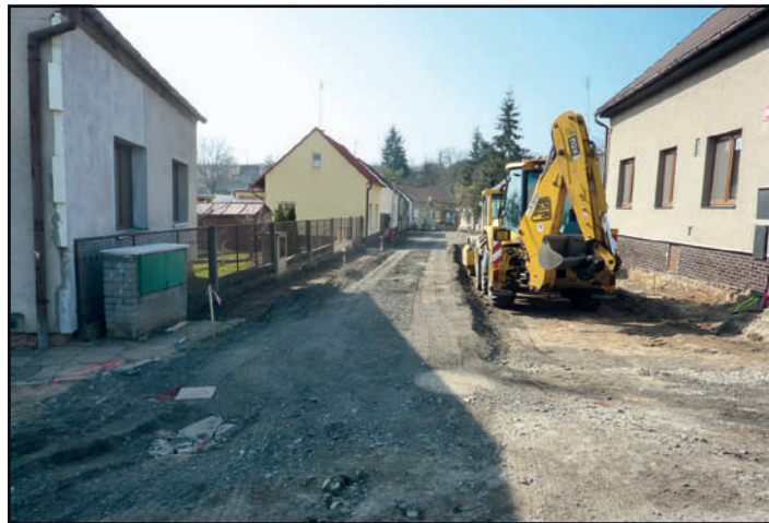
■ Rekonstrukce komunikace byla zahájena i v ulici Jiřího Wolкера
