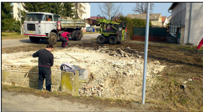
■ Demolice bývalé trafostanice v městské části Kbel
