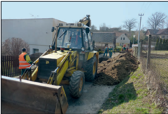
■ Práce na rekonstrukci komunikace v ulici Obodřecká a V Zahradách byly zahájeny v polovině března
