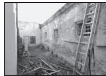
Rekonstrukce bývalé věznice ve dvoře ZUŠ J. A. Bendy byla zahájena (text na str. 2) Foto: MěÚ
