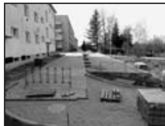
Rekonstrukce náměstí 17. listopadu - dokončování pokládky zámkové dlažby
