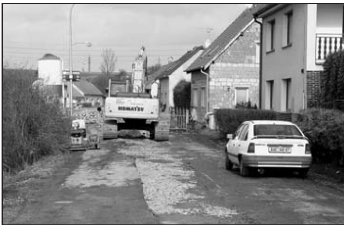
V ulici Pickova, v trase propadlého výkopu po položené kanalizaci, byly zahájeny sanace podloží do hloubky dle průzkumu georadaru
