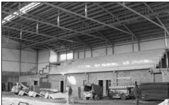
Přístavba tělocvičny k ZŠ Pražská pokračuje. Na snímku je zachycena výstavba tribuny Foto: MěÚ
