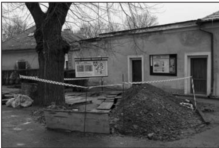
Výkop rýhy pro položení kanalizační a vodovodní přípojky pro veřejné toalety v zámeckém areálu musel být prováděn ručně
