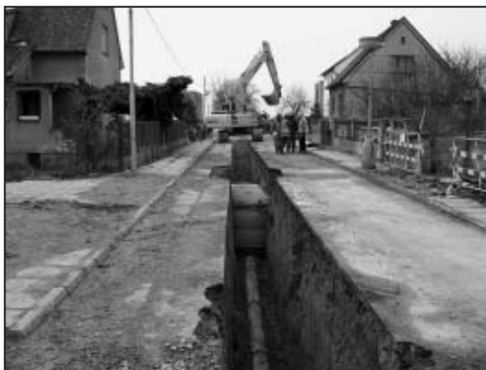
V městské části Dražice Na Štěpnici byl položen hlavní řad Foto: MěÚ
