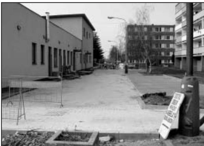
Pokládka zámkové dlažby v ulici Ořechová u Merhautova pekařství je dokončena
