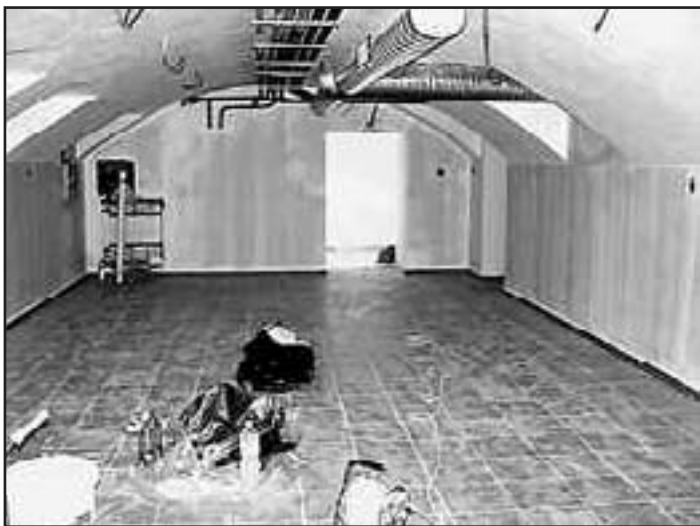
ZŠ Husovo náměstí – vestavba šaten ve sklepních prostorách
