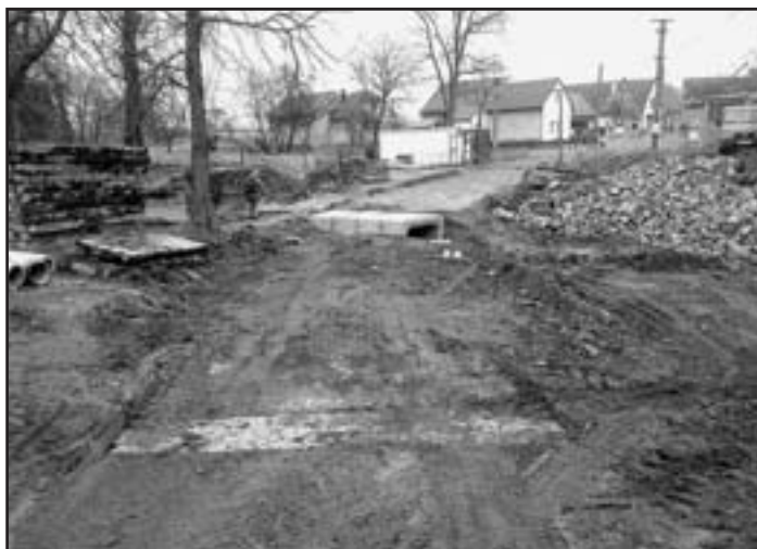
Ministerstvo pro místní rozvoj poskytlo na rekonstrukci komunikací po povodni dotaci – na snímku práce v Dělnické ulici
