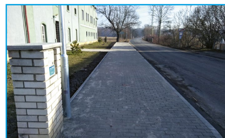
■ Druhá část dokončeného chodníku v Dražicích n. J.
