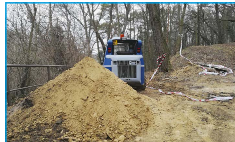
■ Stavba plynovodní přípojky
