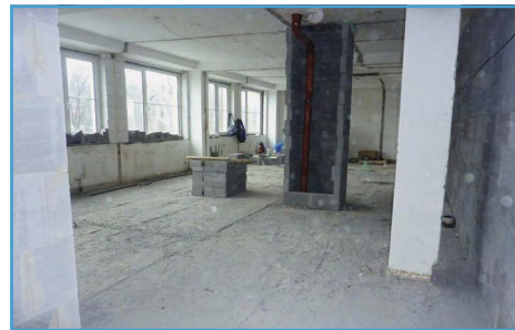
■ V Multifunkčním centru pokračují práce na výstavbě hotelu a fitcentra
