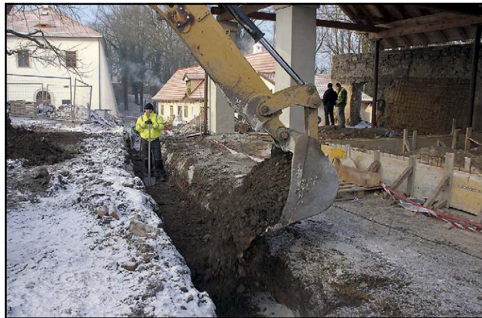
■ Na Plajchu se připravuje výkop pro výtlač kanalizace
