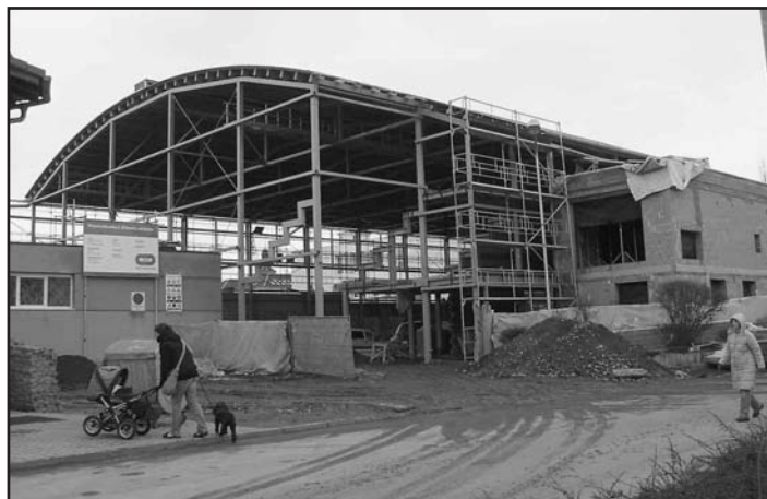
Přístavba tělocvičny k ZŠ Pražská
