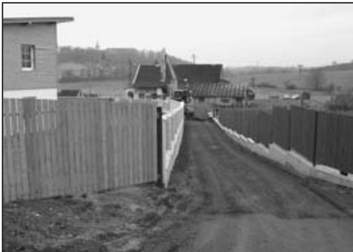
V ulici Pickova byla v polovině února zahájena stavba hlavního kanalizačního řadu Foto: MěÚ
