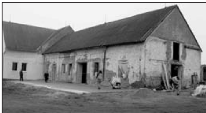
Stavební práce na rekonstrukci objektu v areálu TS města se blíží ke konci
