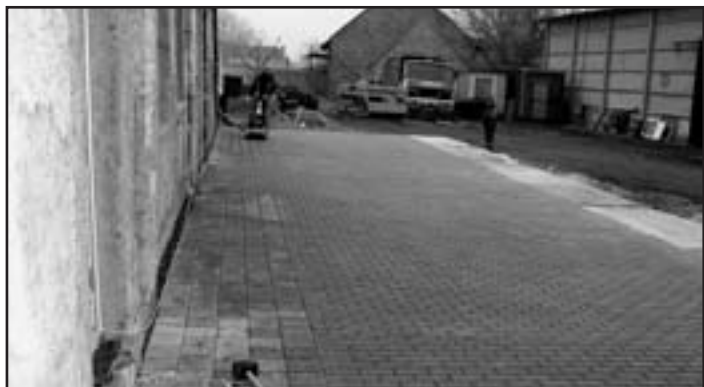
Do rekonstrukce objektu v areálu TS města je zahrnuta i úprava povrchu komunikace
