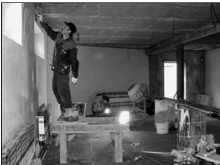
Přístavba a vestavba nových šaten v ZŠ Husovo náměstí
