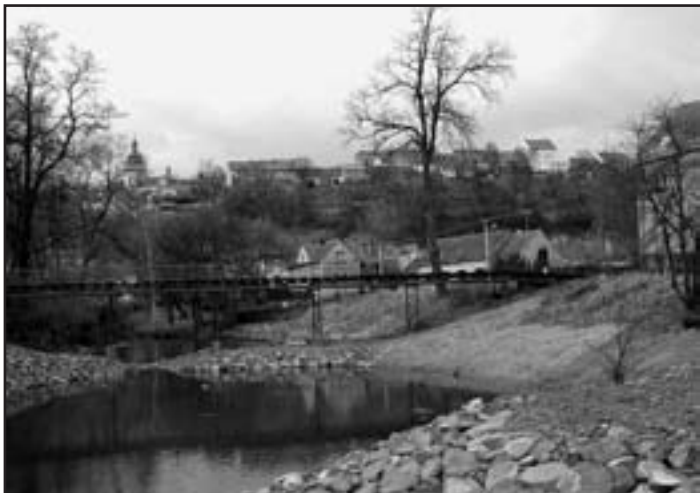
V rámci protipovodňových opatření je dokončeno zpevnění břehů tlní lomovým kamenem. V jarních měsících bude provedeno osetí břehů trávou.
