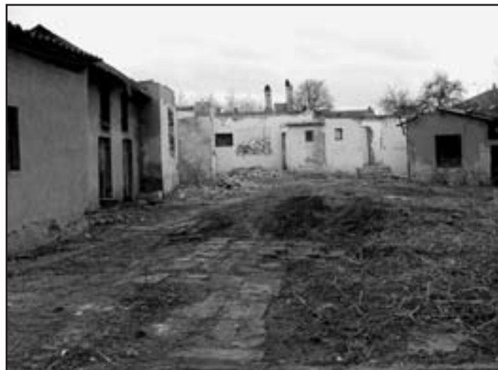
Technické služby města zajišťují demolici čp. 64 v Dělnické ulici
