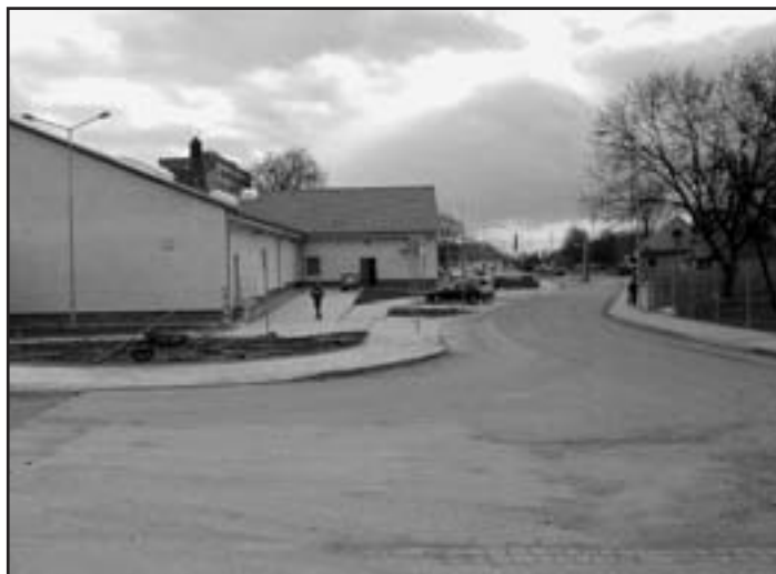
Dokončují se práce na výstavbě venkovního zadního přístupu do Penny marketu
