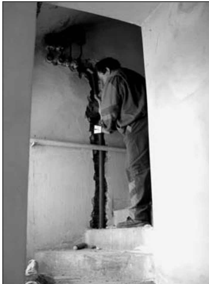
Ve společenském sále v Dražicích probíhá rekonstrukce a přístavba hygienického zařízení
