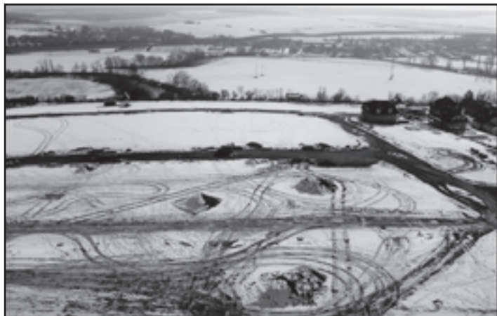
Úprava staveniště v lokalitě Nad Vinicemi
