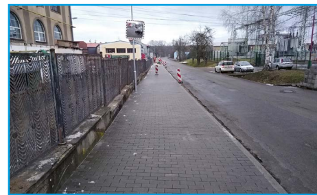
■ Rekonstrukce chodníku před „závodem“ v Dražicích
