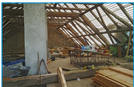
■ Polovina střechy je hotová
