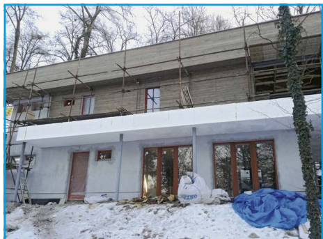
■ Venkovní stěny jsou obloženy, zbývá dokončit druhý nátěr
