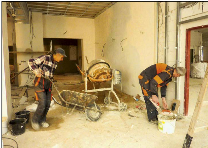
■ Kulturně vzdělávací centrum Záložna - jsou vyzděny příčky, provedeny rozvody elektřiny, vody, kanalizace, topení a zhotovují se vnitřní omítky
