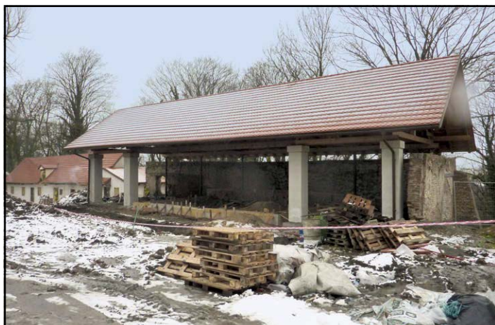
■ Rekonstrukce plochy u zámku a domu čp. 172 na Plajchu – na přístřešku je hotový krov a položena střešní krytina
