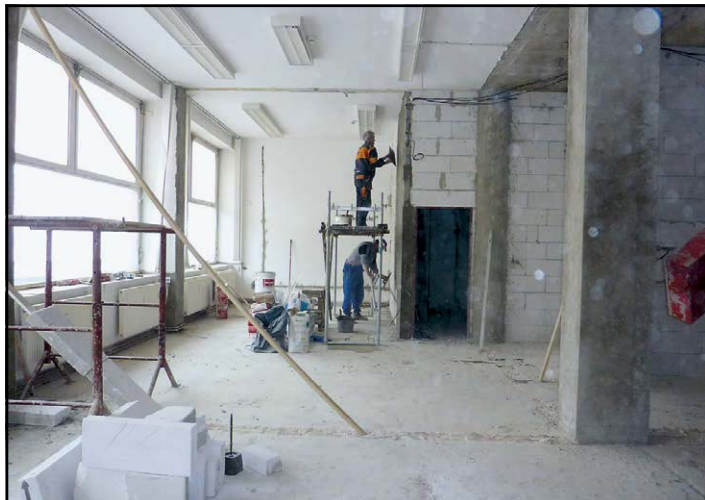
■ Kulturně vzdělávací centrum Záložna - jsou vyzděny příčky, provedeny rozvody elektřiny, vody, kanalizace, topení a zhotovují se vnitřní omítky
