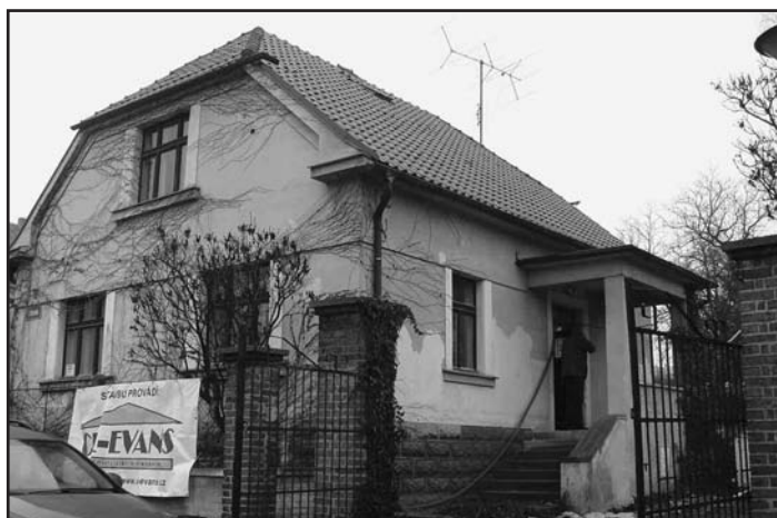
Rekonstrukce čp. 432 na MŠ byla zahájena
