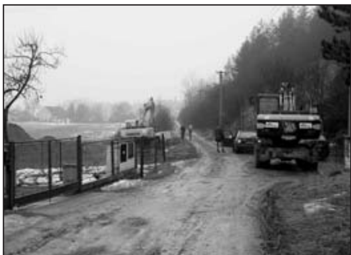
V ulici u Jizery v Dražicích byla zahájena výstavba kanalizace
