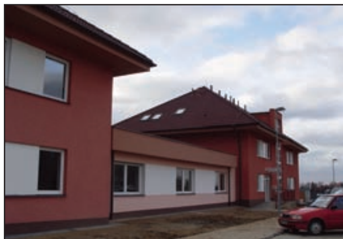
Po dokončení výstavby inženýrských sítí a komunikací v měsíci září 2005 byla výstavba bytových domů v lokalitě Nad Vinicemi zahájena a pokračovala rychlým tempem v roce 2006. Bytové domy mají celkem 61 bytových jednotek. Stavba bude dokončena v průběhu prvního pololetí roku 2007. Prodej bytů v jmenovaných bytových domech byl zahájen na jaře roku 2005
