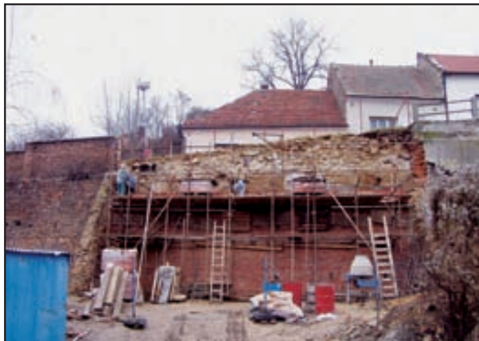
Oprava opěrné zdi ve Smetanově ulici byla zahájena v měsíci říjnu. Termín dokončení opravy je závislý na možnostech daných počasím.
