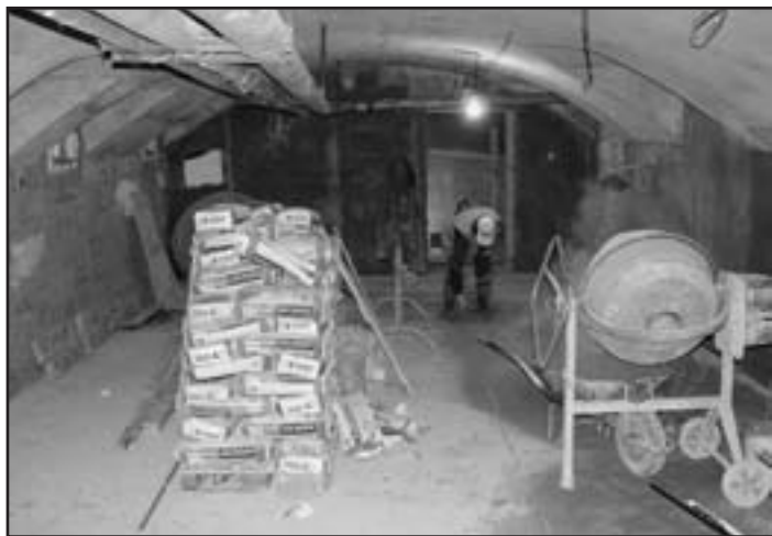
Vestavba šaten ve sklepních prostorách ZŠ Husovo náměstí
