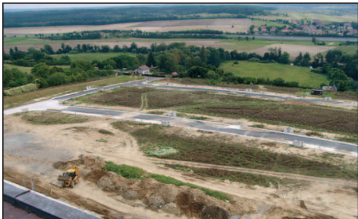
Kolaudací byla v lokalitě Nad Vinicemi ukončena 2. etapa výstavby inženýrských sítí a komunikací a území bylo předáno současným majitelům pozemků na stavbu rodinných a bytových domů.
