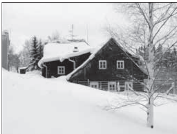
Objekt po opravě
