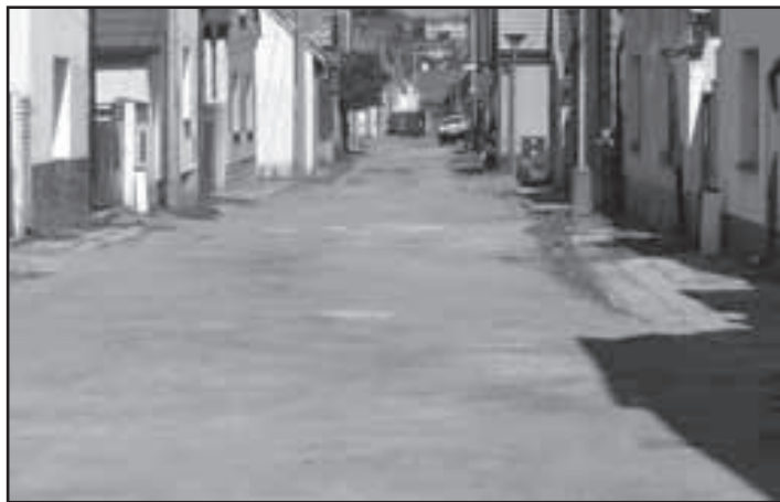
Lipnická ulice před rekonstrukcí komunikace...
