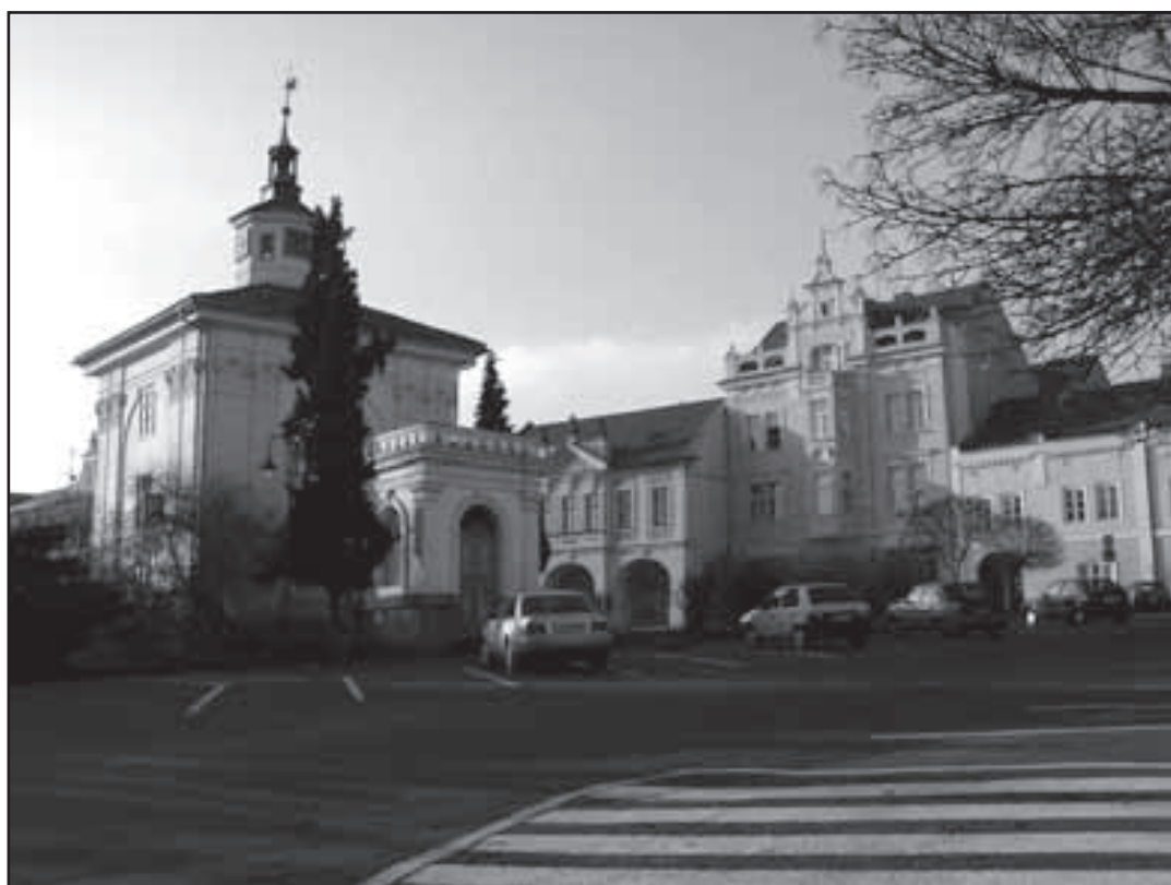
Část Husova náměstí - dům čp. 60 (druhý zprava) po provedené opravě
