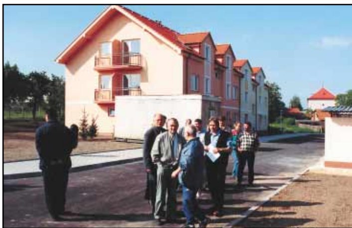
V květnu byla provedena kolaudace nových 33 bytových jednotek v Pražské ulici.
