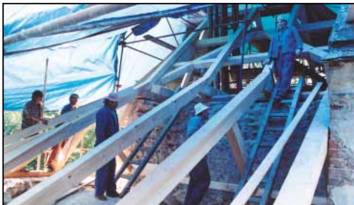
Dokladem péče města o historické památky je i započatá oprava kostela svatého Martina v Dražičích. Firma Daniel Frňka dokončí dílo v roce 2004.
