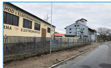
■ Část chodníku v Dražicích před závodem s novým VO před opravou povrchu
