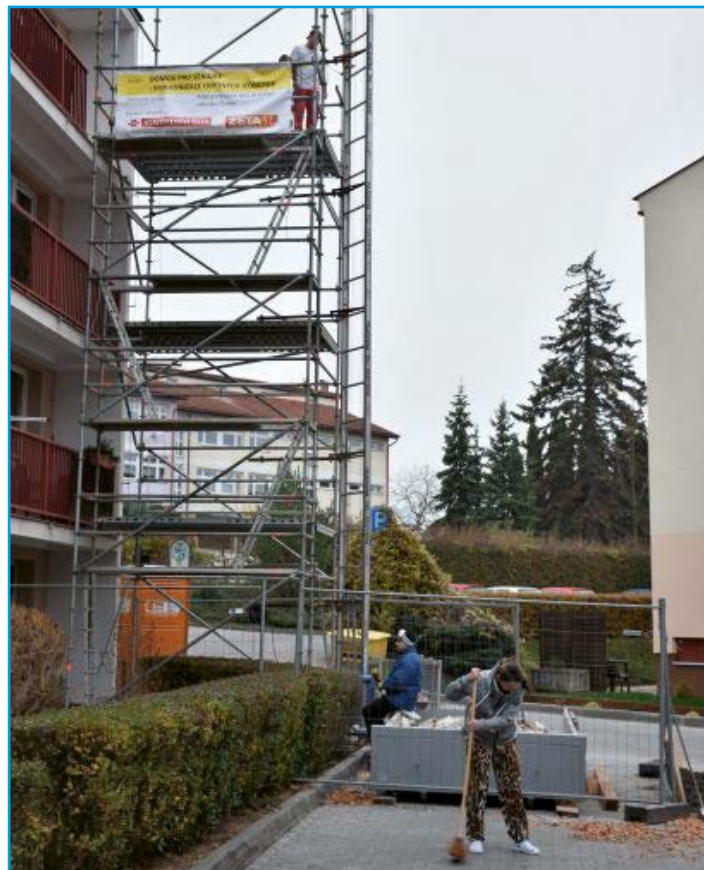
■ Venkovní výtah na vyvážení sutin a dodávky materiálu na stavbu
