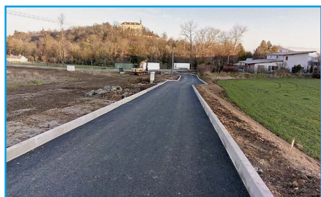
■ V lokalitě Nad Stadionem v Obodří byla položena první vrstva asfaltového krytu nové komunikace
