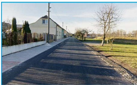
■ V ulici V Olšínách byl položen nový asfaltový kryt komunikace
