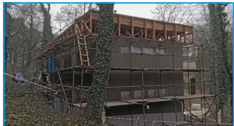
■ Probíhají práce na zateplení a fasádě
