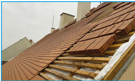
■ Nyní se čeká na dodávku oplechování
