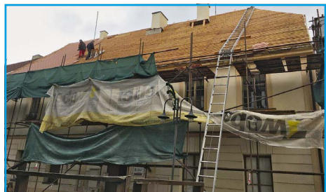
■ Na ZUŠ probíhají pokrývačské práce
