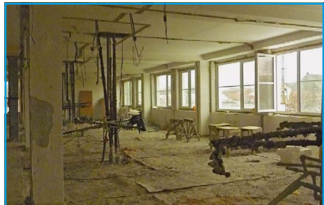
■ Bourací práce v 2. a 3. nadzemním podlaží Multifunkčního centra byly zahájeny v prosinci
