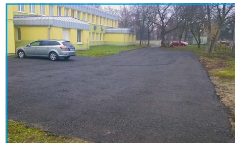
■ Začátkem měsíce prosince provedla firma ZETA Benátky s. r. o. úpravu plochy (parkoviště) za poliklinikou
