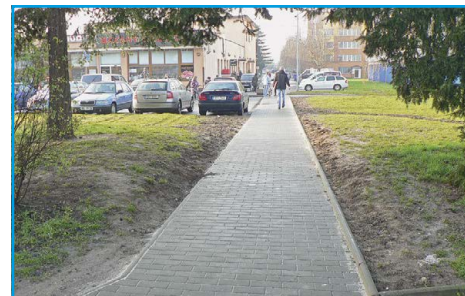
■ Firma ZETA Benátky s. r. o. provedla rekonstrukci chodníku, z části i parkoviště od zastávky autobusů k objektu pekárny firmy Merhaut
