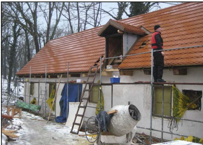
■ Na hlavní budově na Plajchu je hotova střecha, osazeny rámy oken a dveří, hotové jsou hrubé podlahy včetně tepelné izolace a vnitřní omítky
