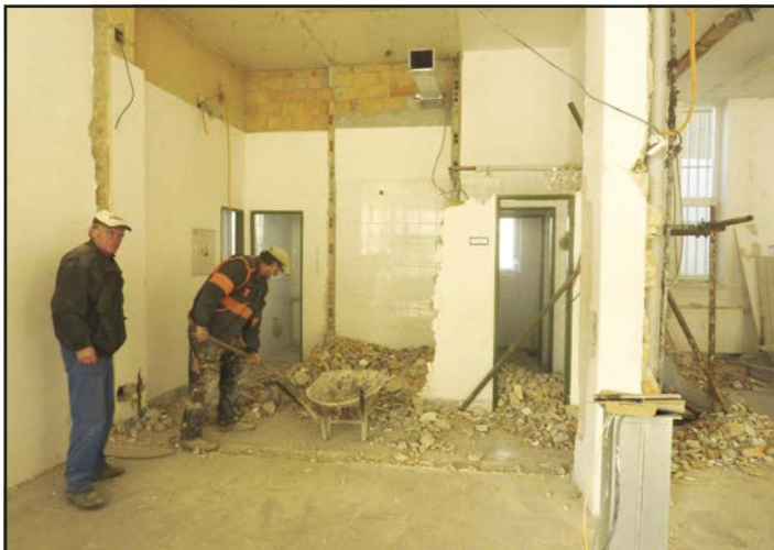
■ Kulturně vzdělávací centrum Záložna, zhotovitel: firma ZETA, s.r.o. Benátky nad Jizerou - všechny vybouraný materiál byl odvezen a byly zahájeny práce na novém interiéru
