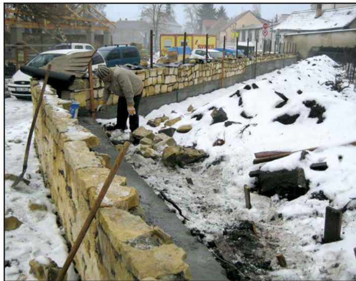
■ Opěrná zeď na Plajchu u školní družiny
