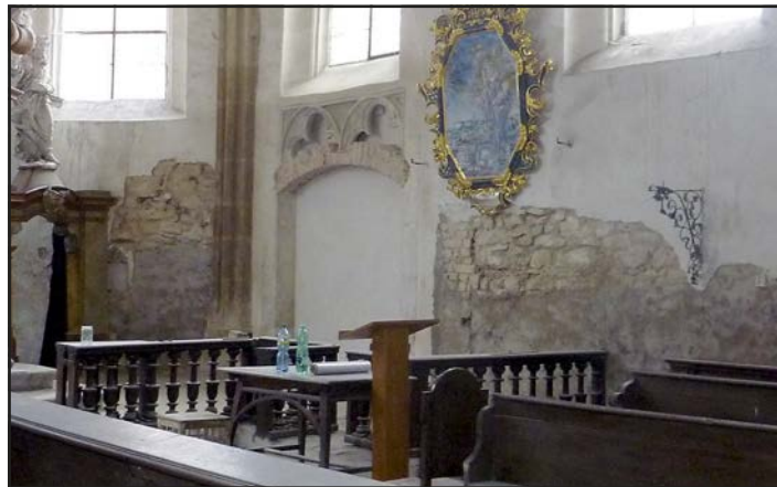
■ Práce plánované na rok 2012 v kostele Narození Panny Marie v zámeckém parku byly dokončeny
