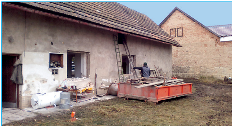
■ Demolice čp. 53 v ulici Pražská
