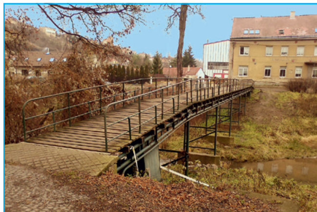
■ Připravuje se oprava dřevěné lávky přes slepé rameno Jizery
