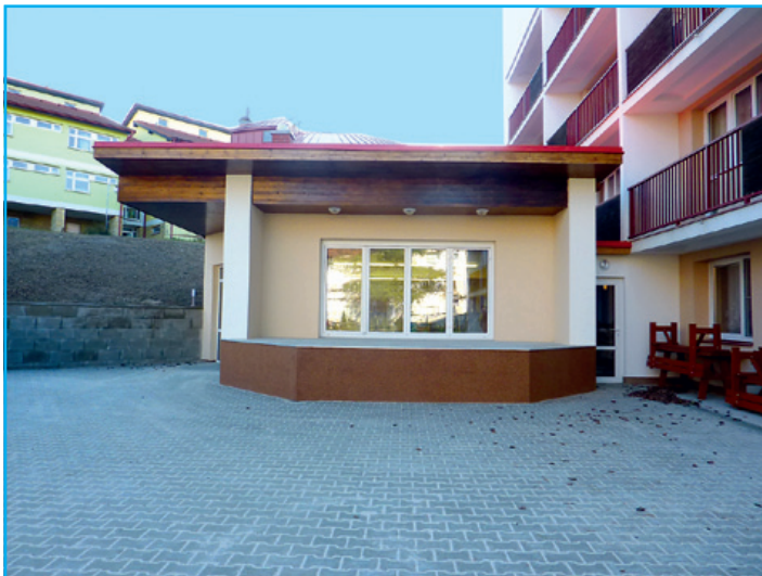
■ Přístavba společenského sálu k budově Městského centra komplexní péče byla dokončena
