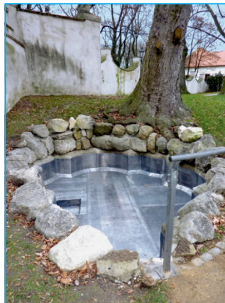
■ Na jaře bude bazének po mnoha letech napuštěn vodou
