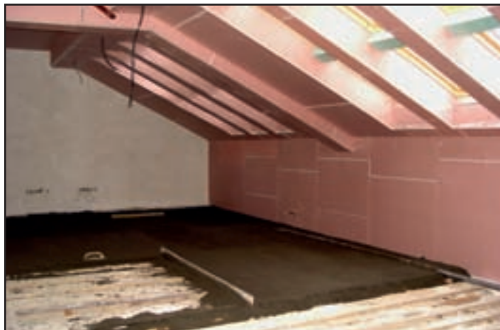
Jednotlivé místnosti se postupně upravují v závislosti na postupu prací na výměně střešní krytiny Foto: MěÚ
