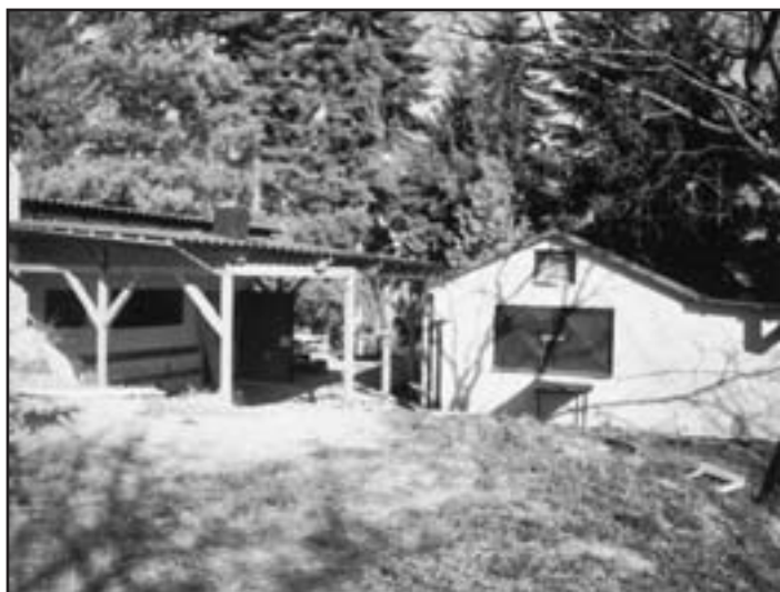
Na chatě „Kochánky“, byla provedena přístavba pergoly, udírny a ohniště
