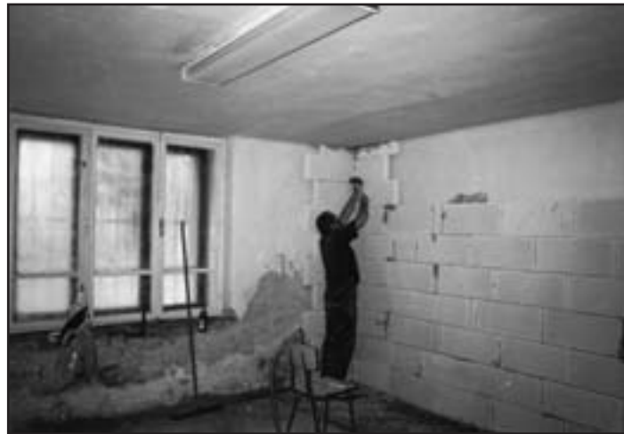
V měsících září až listopad 2006 byla provedena rekonstrukce kuchyně v rybářské klubovně v ulici Pražská
