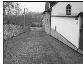
Rekonstrukce zbývajících částí ulice Smetanova bude pokračovat v roce 2010. Stávající část rekonstrukce je ukončena u trafostanice
