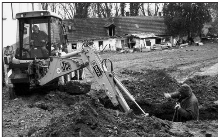
Práce na sídle školní družiny ZŠ Husovo náměstí v areálu zámku pokračují. Na snímku je zachyceno napojování na kanalizaci ze zadní části budovy
