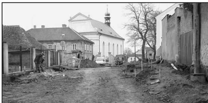
V ulici Vágnerova probíhají přeložky sítí
