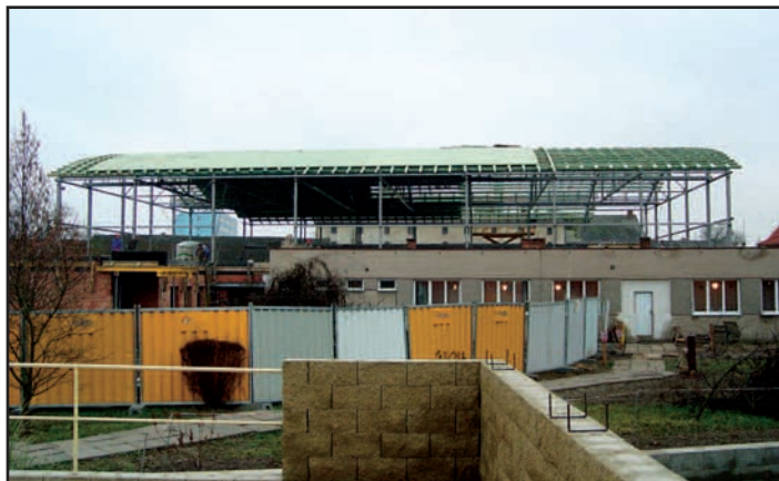
Přístavba tělocvičny k ZŠ Pražská – v polovině listopadu byla zahájena montáž ocelové konstrukce tribuny a následně střešní konstrukce haly
