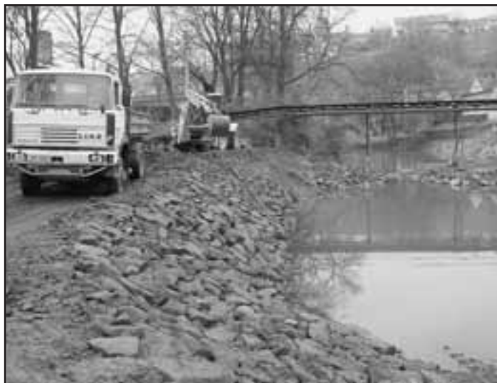
Součástí akce „oprava komunikací po povodni“ je i oprava břehu tůňí lomovým kamenem. Opravu provádí firma H-Intes, s. r. o., Mladá Boleslav
