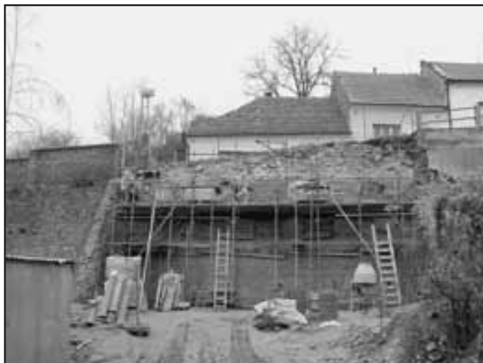
Rekonstrukce opěrné zdi ve Smetanově ulici pokračuje – na snímku je zachycen stav v první pracovní den roku 2007
