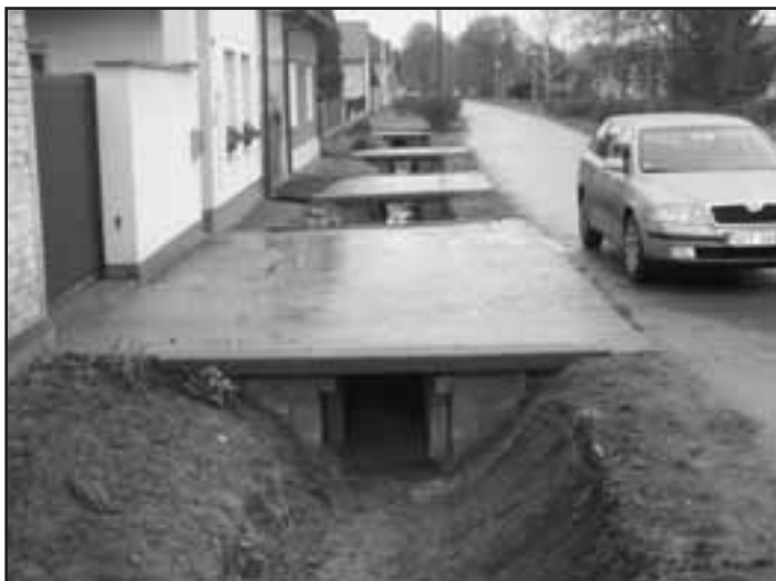
Oprava propustek a vjezdů přes odvodňovací příkop Foto: Marek Mařík
