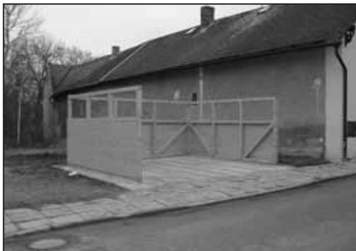
Ohrazené stání pro kontejnery na tříděný odpad v Mělnické ulici a Platanové ulici
