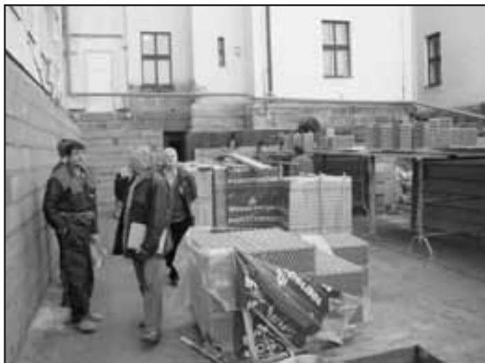
ZŠ Husovo náměstí – přístavba a vestavba nových šaten
