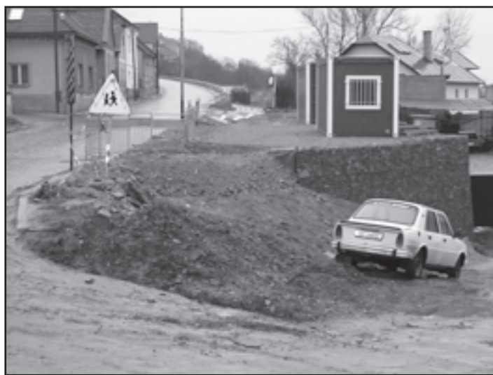
Rekonstrukce Podolecké ulice, stav k 3. lednu 2005 Foto Marek Mařík
