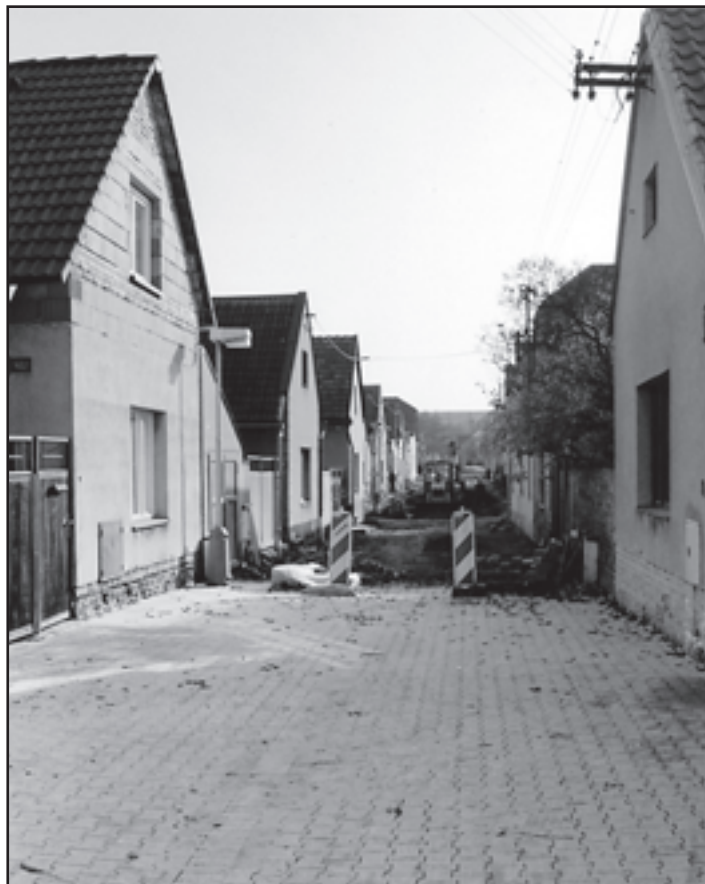
Rekonstrukce Lipnické ulice
