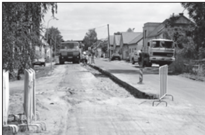
Výstavba kanalizace ve Kbele
