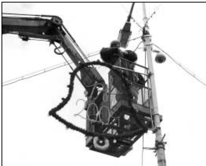
Montáž kamerového systému na Burse
