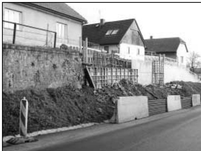
Oprava opěrné zdi v Obodři
